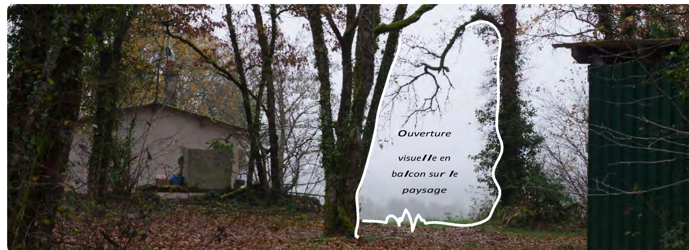
(11) Vue depuis le cœur du boisement coiffant les hauts de la ZIP au Sud. Cette bâtisse est dissimulée par la végétation et ne constitue pas de repère visuel depuis les points hauts voisins.
